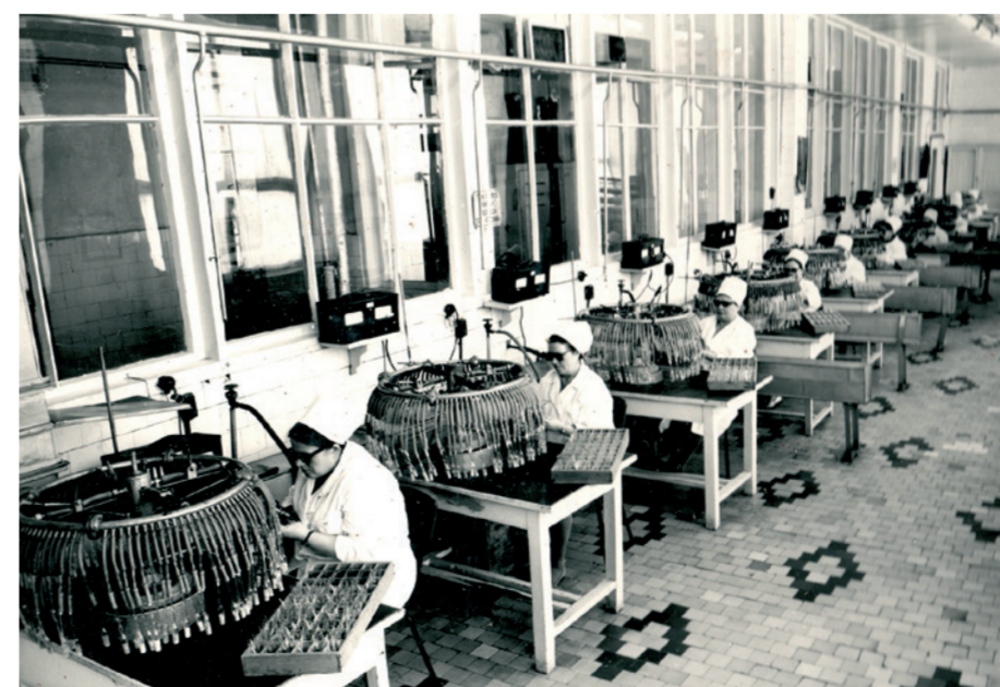
Запайка вакцины под вакуумом (архивное фото, 1969 год)
