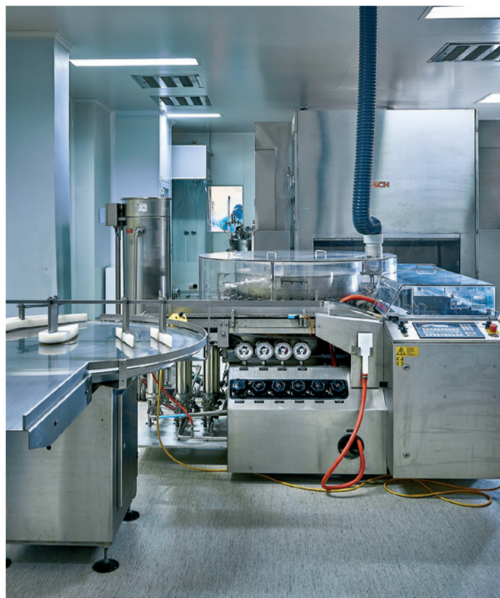
Узел мойки и стерилизации линии Bosch ФКП «Ставропольская биофабрика»
